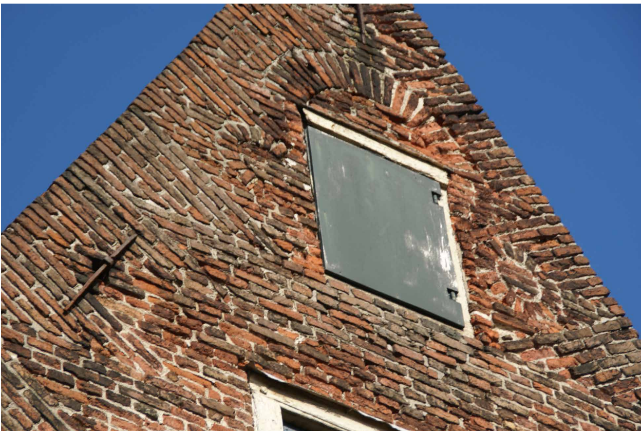
Afb. 16. Detail van de geveltop aan de achterzijde. Foto auteur, 2008.
