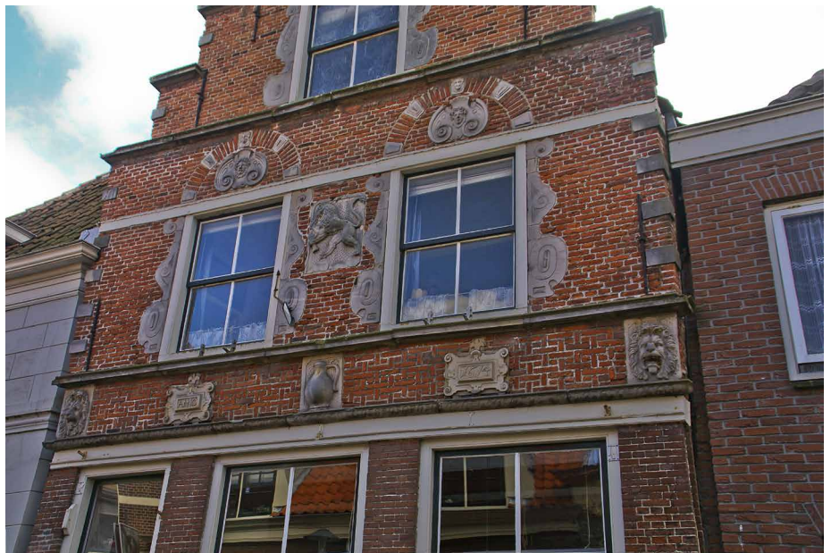
Afb. 11. De voorgevel. Foto auteur, 2008.
