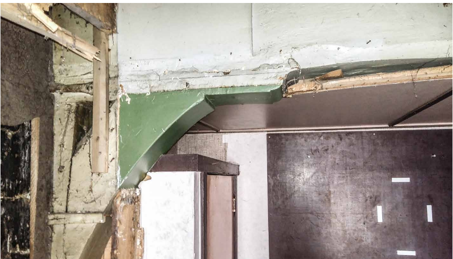
Afb. 24. Het derde gebint van voren op de verdieping. gezien in de richting van de voorgevel. Foto auteur, 2016.
