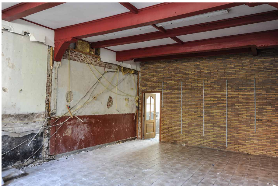
Afb. 17. Begane grond naar achteren gezien. Het tweede gebint van voren (links) beschikt nog over muurstijl, korbeel en sleutelstuk, waarop een zware dekbalk ligt. Foto auteur, 2016.
