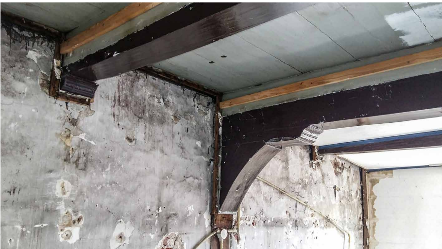
Afb. 23. De verdieping, gezien naar de achtergevel, van voor naar een trek balk met console, een compleet gebint en weer een trekbalk. Foto auteur, 2016.
