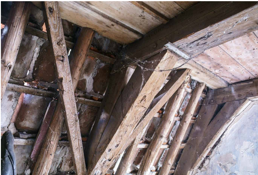
Afb. 27. Juk met telmerk 9 in gegutste stippen. De jukken hebben aan weerszijden windschoren, die van juk naar worm lopen. De pannen hangen aan de panlatten, die bevestigd zijn aan de sparren. De kieren tussen de pannen zijn dichtgesmeerd met mortel. Foto auteur, 2008.
