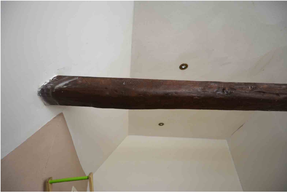
Afbeelding 22. Restanten van de eiken kap,; een juk met een afgezaagde dekbalk met daarover in de lengterichting van de kap een eveneens eiken worm. Foto Auteur.
