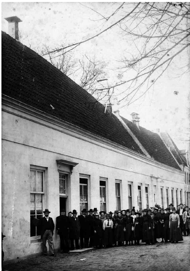
Afbeelding 3. De Hoogere Burgerschool vanaf de Westerstraat, gezien in westelijke richting. Foto uit 1899. Collectie Oud-Enkhuizen.
