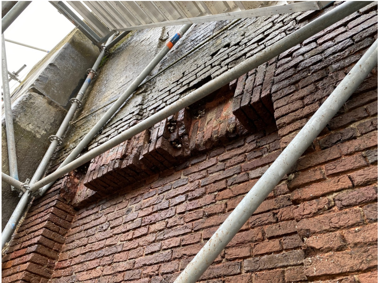
Uitsparing in sluismuur ten behoeve van inlaatschuif
