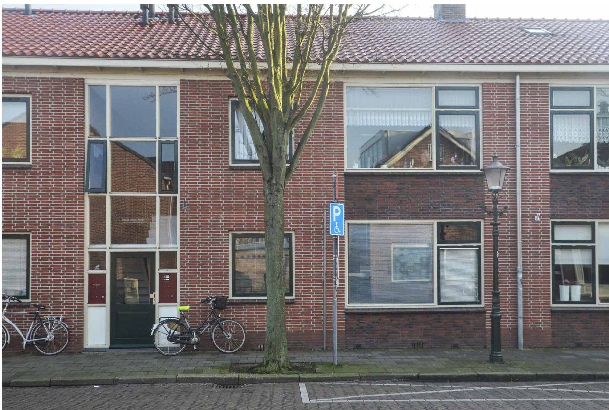
Afb. 11. Voorgevel woonblok Spoorstraat. Foto auteur.
