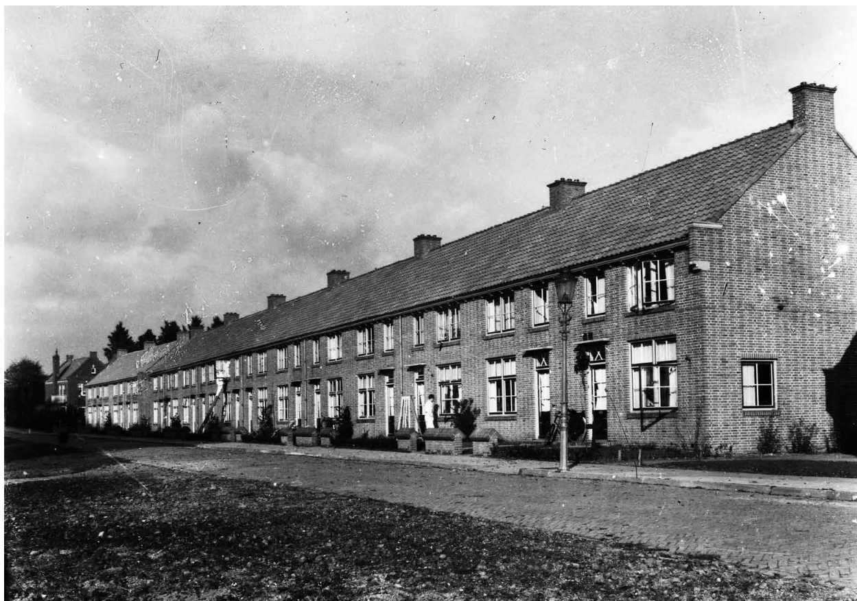
Afb. 6. Het lange blok van 12 duplexwoningen type C kort na de oplevering, gefotografeerd door A. van Rossem op 30 november 1949. Het houtwerk moest nog geschilderd worden. Archief Oud Enkhuizen nr. 31478.
