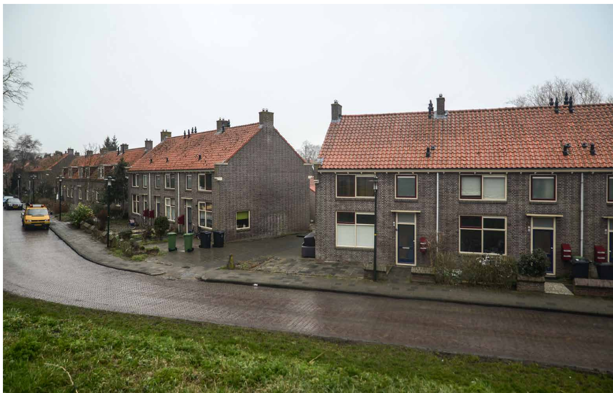
Afb. 11. De Oranjestraat gezien naar het noorden. Rechts het meest zuidelijke blokje. Foto auteur.
