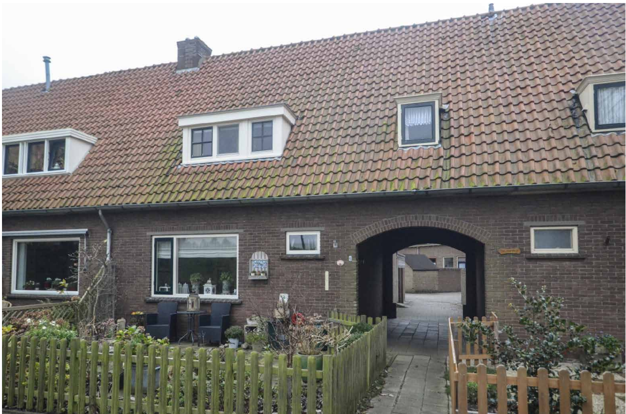
Afb. 17. De poort naar de achtererven in het eerste blok woningen uit 1940 aan de Nanne Sluisstraat. Foto auteur.
