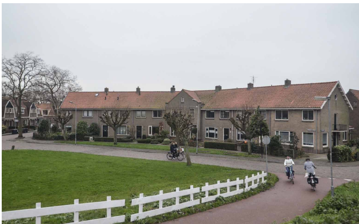
Afb. 11. Het Wethouder de Vosplein gezien naar het zuidwesten met de door Kramer ontworpen woningen volgens het stedenbouwkundige plan van Schaap. Foto auteur.
