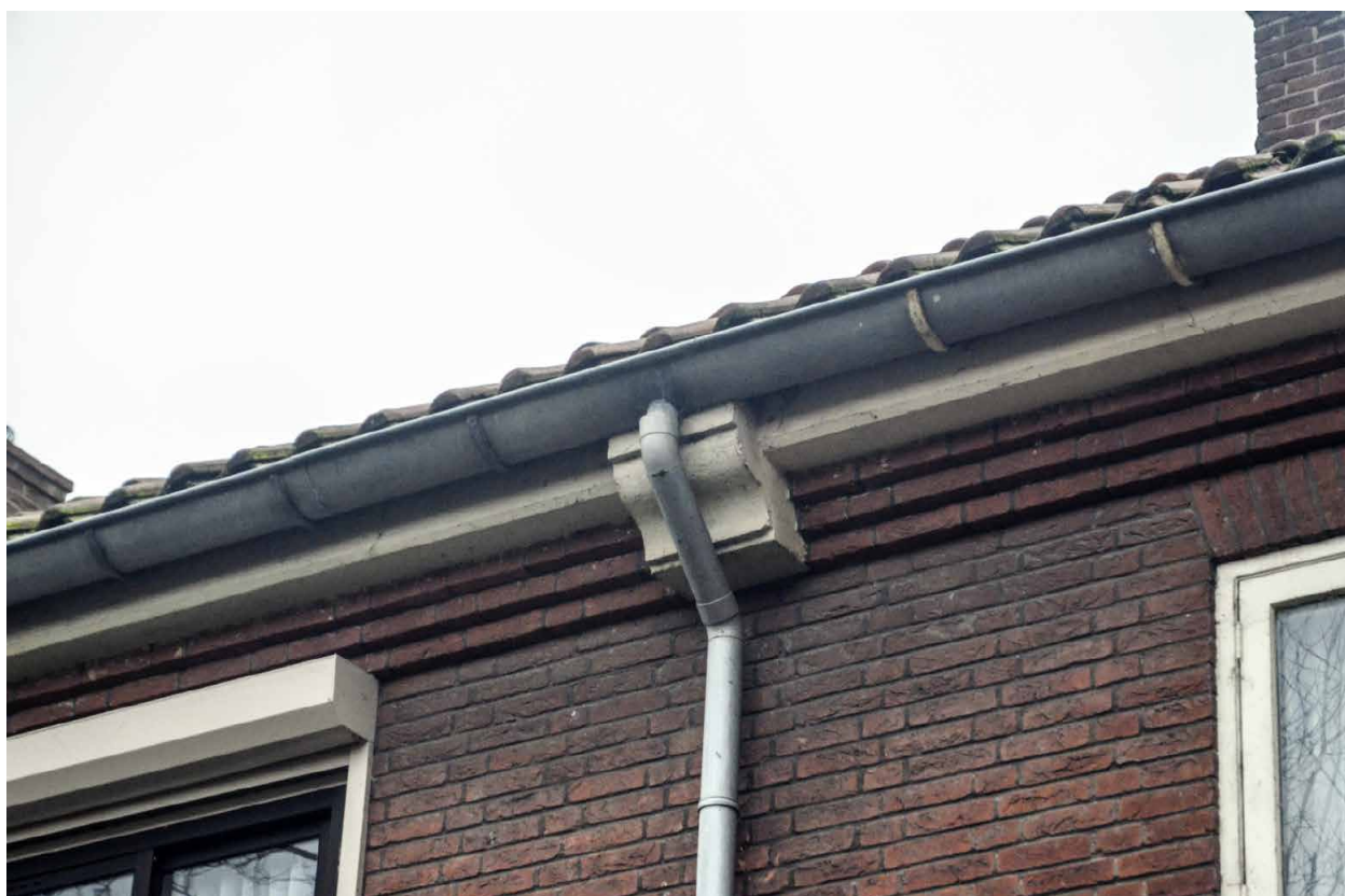
Afb. 23. Detail van dezelfde woningen: de goot is gevestigd aan de betonnen plaat die dient als vloer voor de zolder. Foto auteur. Afb. 20. Blauwdruk van de zijgevel van de vijf woningen van de Friese architect Feddema aan de Molenweg uit
